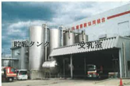
ローリー車で集めた生乳は工場に直接搬入されるのではなく、一旦クーラーステーション(冷蔵の貯乳タンク)へ集められる。
